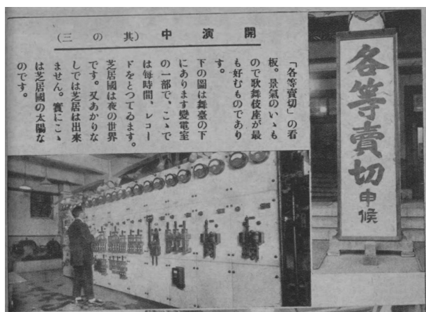
図2 歌舞伎座の変電室 39)
