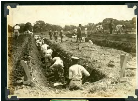
築橋、交通之濠構築
