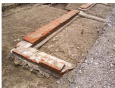
建物のレンガ積み基礎
