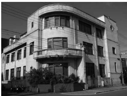
写真7 左京区役所庁舎 1931年竣工・RC造 2008年8月24日撮影
