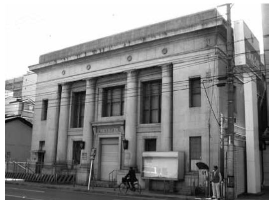
写真4 旧・第一銀行西陣支店 1936年竣工・RC造・西村好時設計 2005年10月21日撮影
