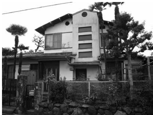
写真11 左京区:葵A邸 2005年12月2日撮影
