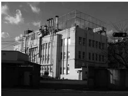
写真5 第一工業製薬・研究西棟 1937年竣工・RC造 2006年12月28日撮影
