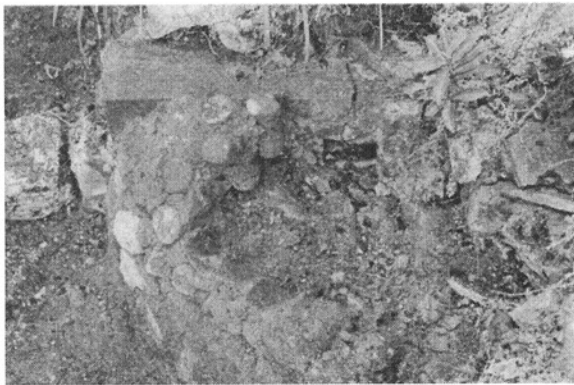
胴木間天井のクレ
